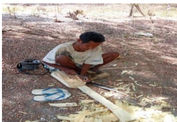
Gambar 1.6 Proses Pemasangan triplek penutup (ek ten) Sumber: Dokumentasi Peneliti, Desember 2023
